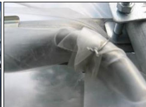
**59. Bâche principale :** Détail de ligature des angles de porte par un fil galvanisé (environ 1.3mm non fourni) vue de l'intérieur de la serre.
