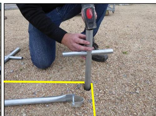
**3. Structure :** une fois l'emplacement repéré, enlever la barre filante et poser une première croix d'extrémité à l'aide d'un marteau. Utiliser une calle en bois si nécessaire
