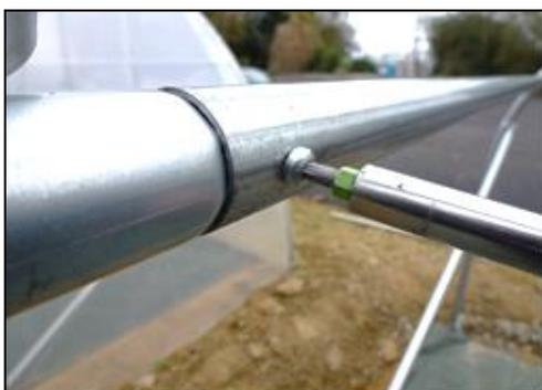
**23. Structure** : les éléments de barre filante sont assemblés entre eux par une vis autoforeuse qui se pose à l'aide d'un embout Torx (non fourni) et d'une visseuse.
