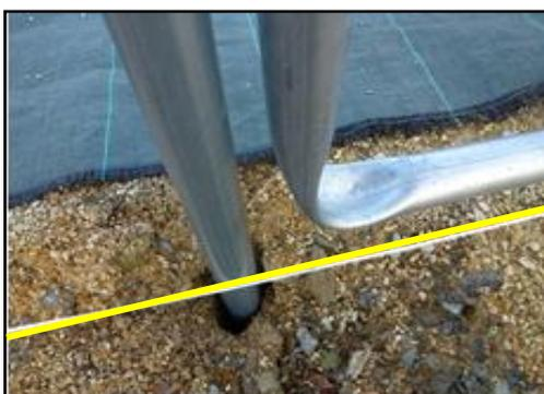
**34. Pignon porte** : le montant est planté en terre en partie basse. Vue de l'extérieur de la serre. (il peut si nécessaire être recoupé ou scellé dans du béton).
