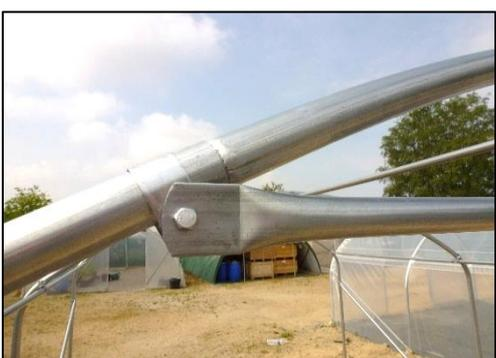
**29. Pignon porte** : poser de niveau les deux traverses horizontale (2,10m + 1m à assembler avec 2 vis auto foreuses). Fixer les traverses sur l'arceau avec deux colliers U de 40mm. Cette fois le plat percé doit se trouver à l'extérieur de la structure.
