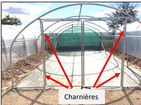
**50. Option porte double :** fixer les 2 charnières droites sur le montant droit et les deux charnières gauches sur le montant gauche avec des vis auto foreuses (nécessite un embout Torx).
