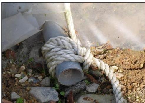
**55. Bâche principale :** passer la cordelette sous le débord de croix, tendre la cordelette et la nouer en réalisant des demi clé,
