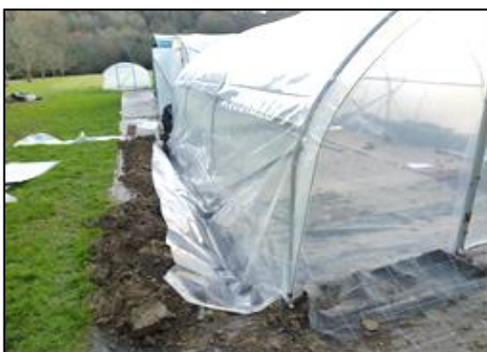
**53. Bâche principale :** centrer la bâche sur la structure, la cordelette dans le sens de la largeur qui est de 10m. Vérifier qu'aucun fil Deltane ne dépasse. Descendre la bâche dans la tranchée de chaque côté. (photo non contractuelle).
