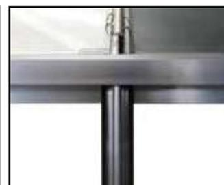
Fixation des profils de vitrage sur la traverse haute
