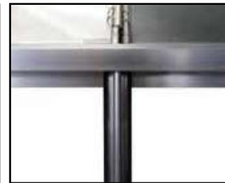
Fixation des profilés de vitrage sur la traverse haute
